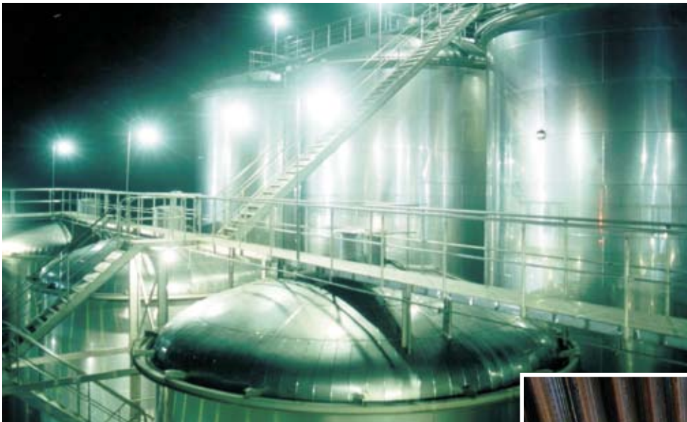
Tanque de almacenamiento de cerveza
